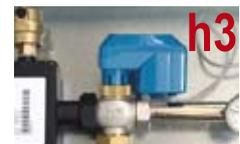
**h3-** Servomotore elettrico
