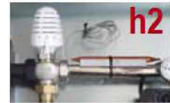
h2- Attuatore termostatico
